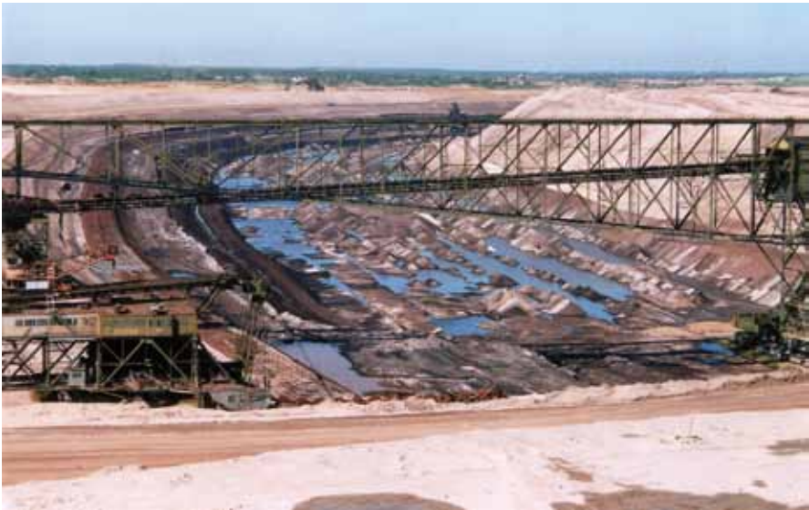
Abb.6: Die Abraumförderbrücke (AFB) 17 im Tagebau Espenhain 1995, Foto: Günther Schönfelder.
